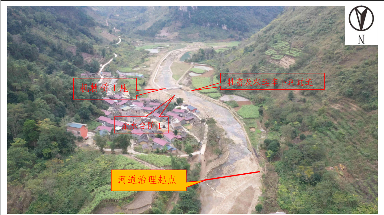
河道治理现状 1（2023.1）
