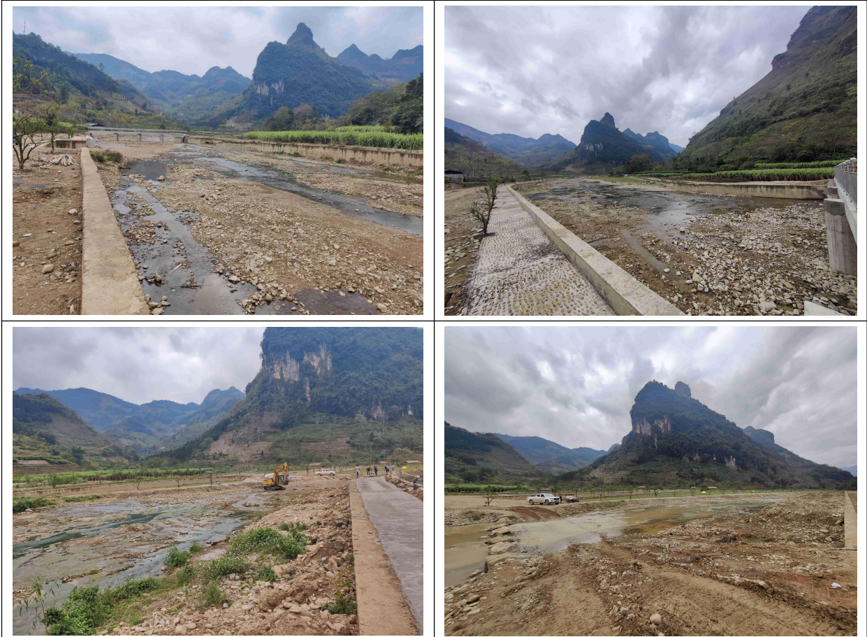
河道内部现状（2023.1）
