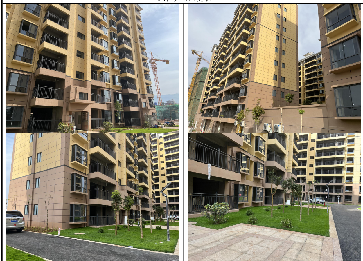
建构筑物区现状
