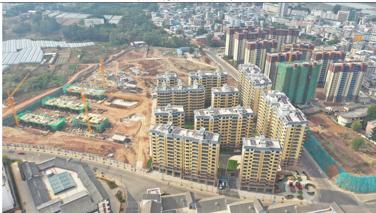
项目区现状（2022 年 3 月）
