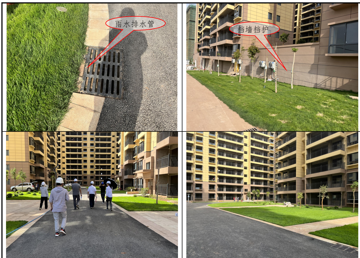
道路硬化区现状
