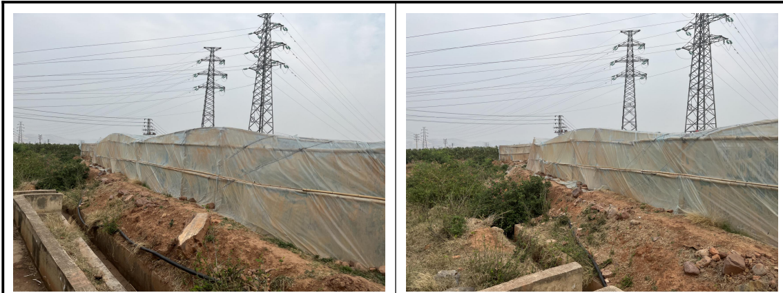
建设村组团哨房变电站背后坝塘回填造地点
