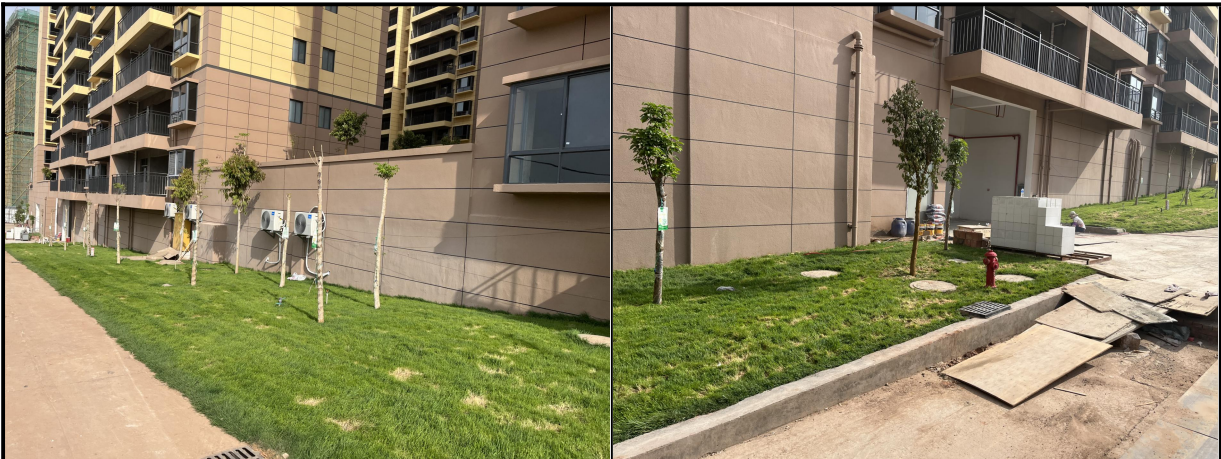
实施的重力式挡墙
