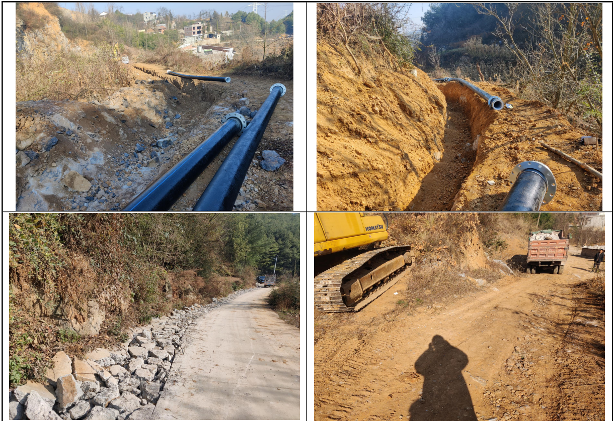
保家山附近布设输水主管施工现状 3 (2023.12)
