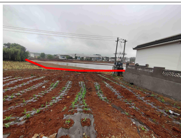
桃源水库周边布设输水主管区域现状（2023.6）
