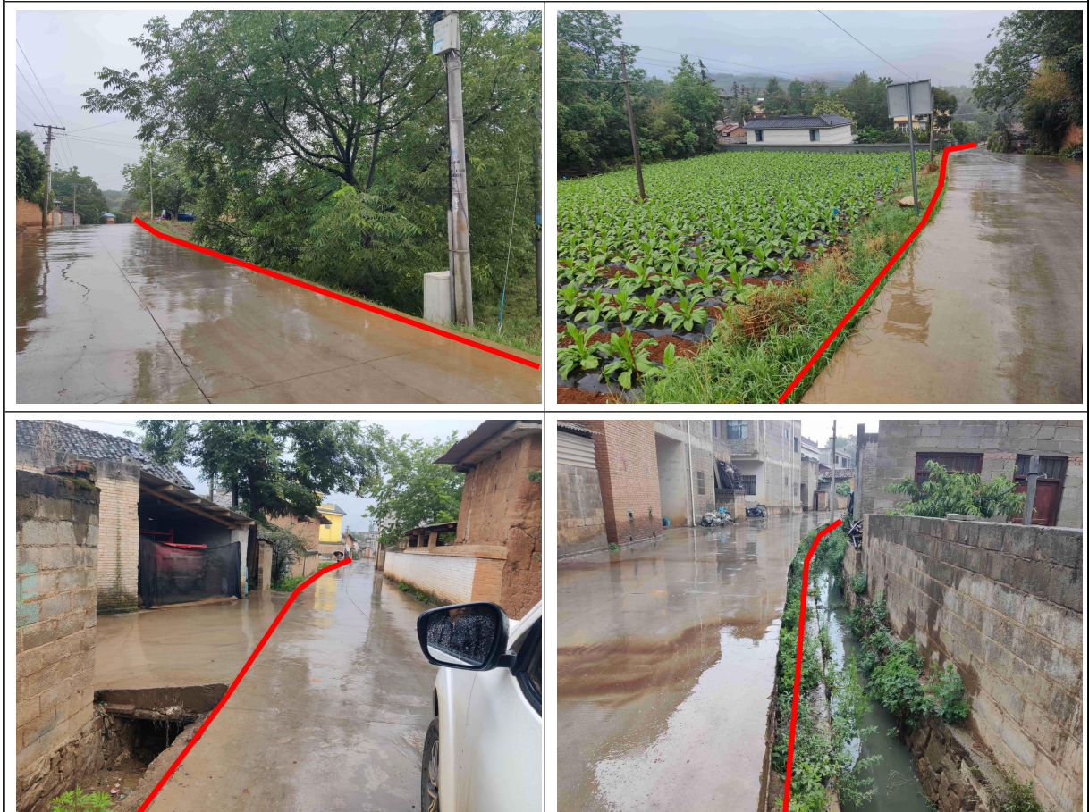
桃源水库至保家山居民点周边乡村道路安装输水主管区域现状 4 (2023.6)
